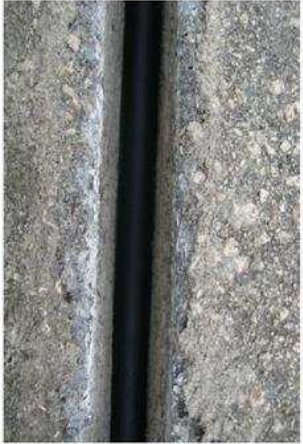
Scavo aperto con tubazione posata
